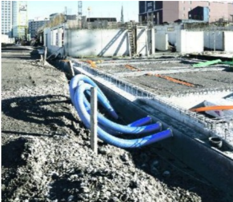
Dortmunder U: Auf dem ehemaligen Brauereigelände entstehen als ÖPP zwei Berufskollegs, ein Kreativzentrum und eine Parkanlage.
